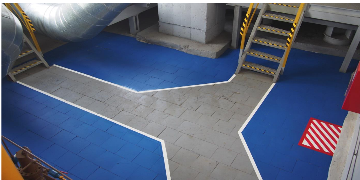
Рисунок Е.1, лист 1 – Примеры организации в производственных зданиях и помещениях вертикальной и горизонтальной разметки
